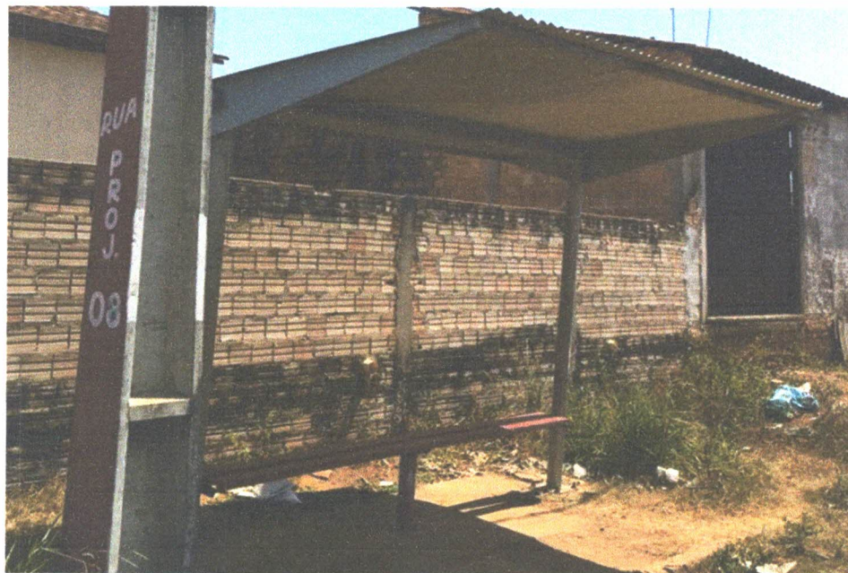
Figura 38 - Ponto de ônibus na Rua Projetada 8, esquina com a Rua Projetada A.
