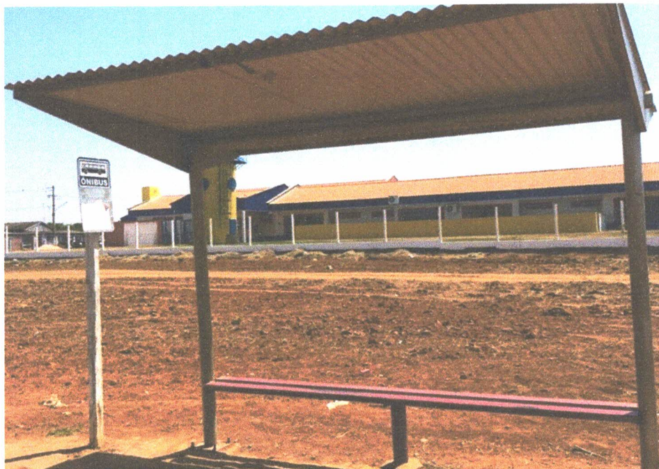
Figura 34 - Ponto de ônibus na Avenida Sebastião de Matos, esquina com a Estrada Sabrina.
