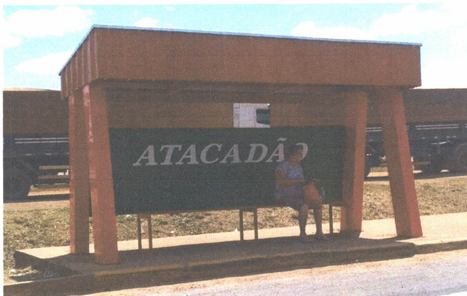
Figura 32 - Ponto de ônibus na Rua João Pedro Moreira de Carvalho, em frente ao Supermercado Atacadão.
