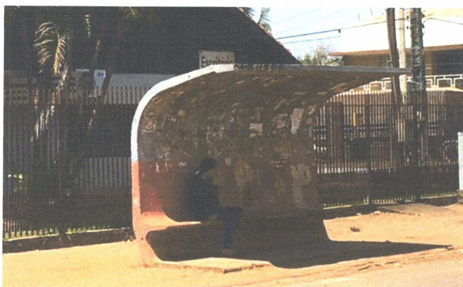
Figura 39 - Ponto de ônibus na Rua João Pedro Moreira de Carvalho, próximo ao Viaduto.
