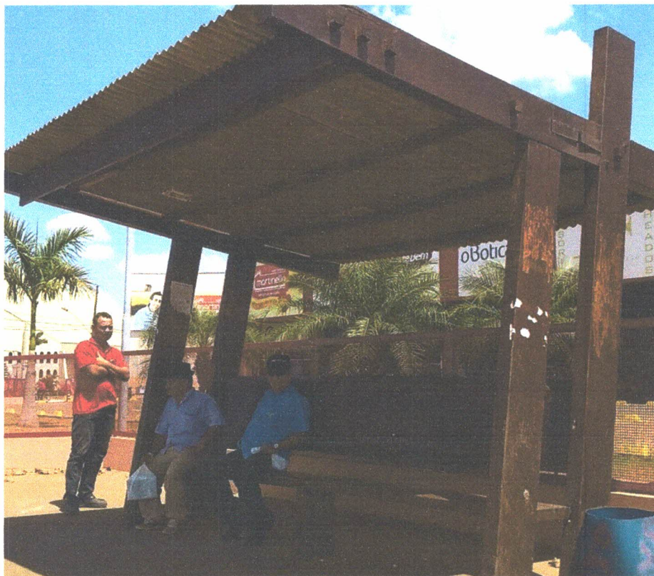
Figura 14 - Ponto de ônibus na Rua Colonizador Ênio Pipino, em frente ao Machado Supercenter.
