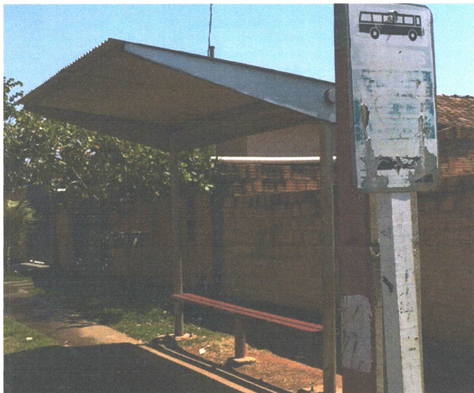
Figura 37 - Ponto de ônibus na Rua Projetada 2, esquina com a Rua Projetada A.
