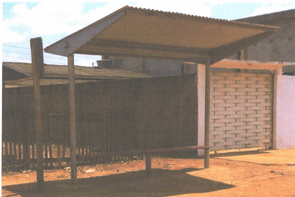
Figura 56 - Ponto de ônibus na Rua Gramado, esquina com Rua Maraú.
