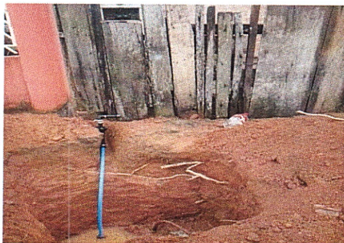
Figura 7. Implantação de ligação nova – Rua Fortaleza
