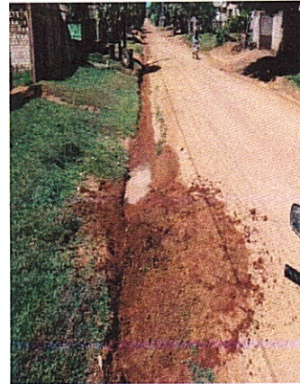
Figura 23. Realização de conserto em rede DN 60 mm
