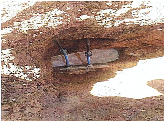
Figura 24. Reparo em rede de água DN 60 mm – Av. Rocha Guimarães
