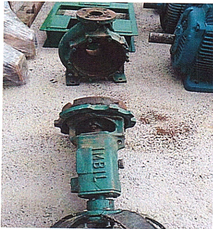
Figura 32. Manutenção da bomba reserva
