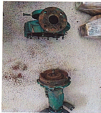
Figura 33. Manutenção da bomba reserva
