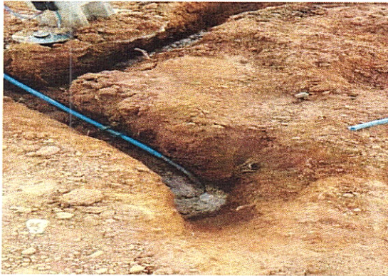
Figura 15. Instalação de nova ligação – Avenida Chico Mendes
