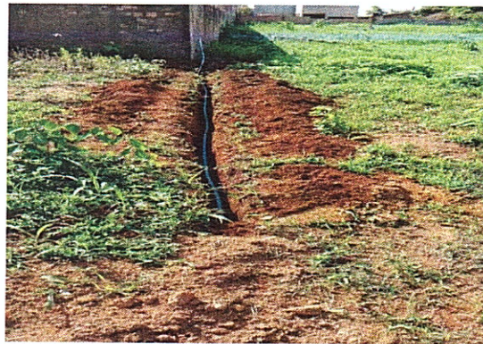
Figura 17. Instalação de nova ligação – Avenida Antônio Castilho
