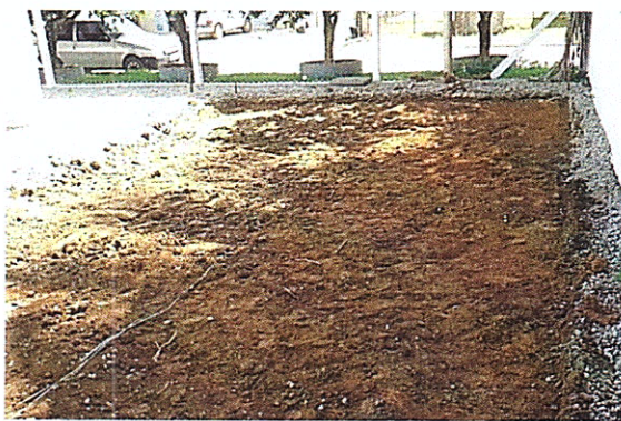
Figura 2. Preparação do local onde será construída a nova ETA
