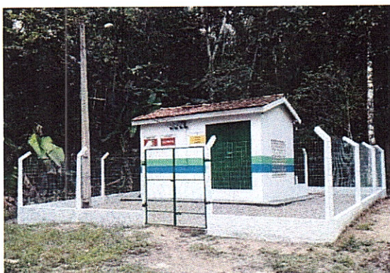
Figura 18. Reforma na captação de água
