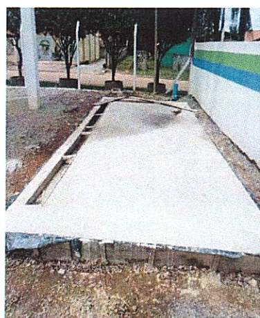
Figura 3. Concretagem da base da ETA
