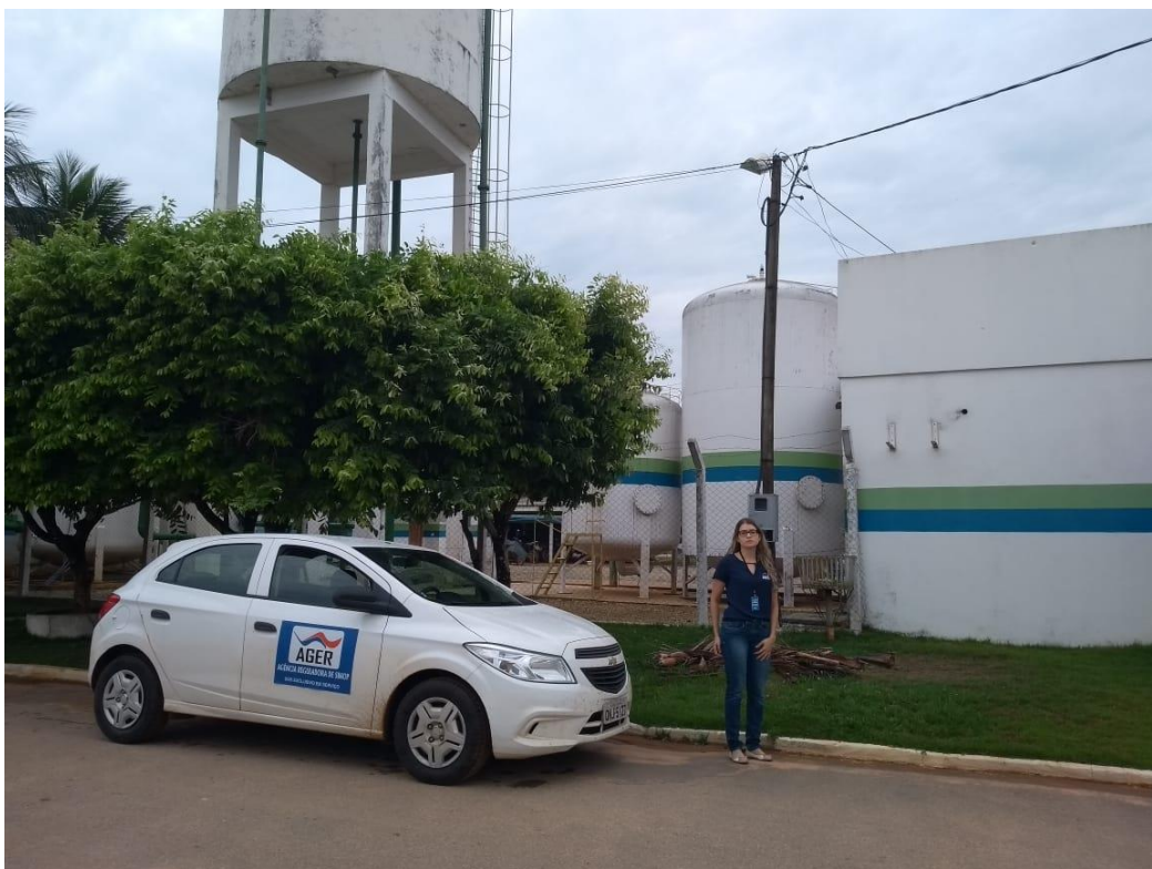
Figura 1 – Visita técnica às instalações da Concessionária Águas de Carlinda.
