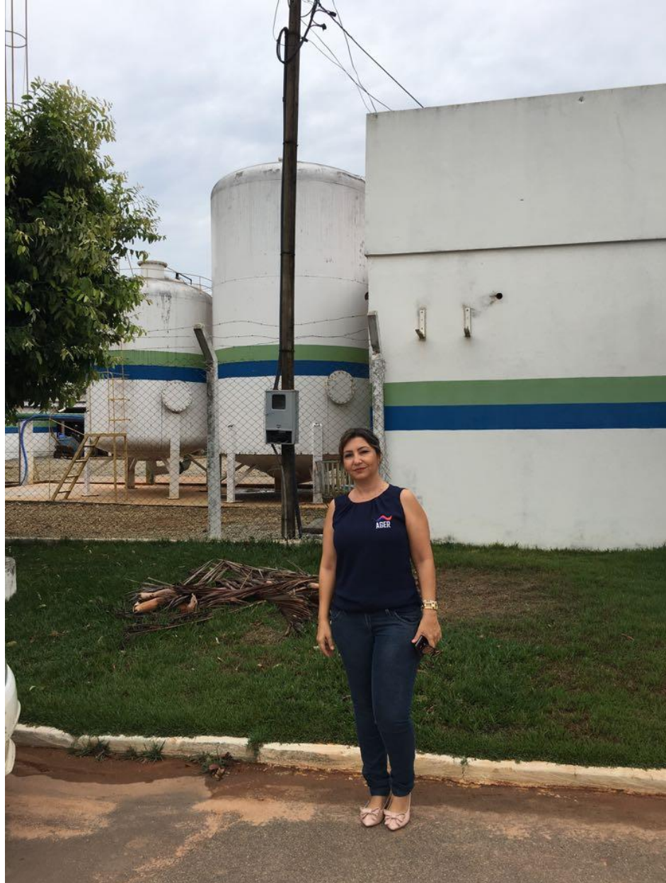
Figura 6 – Visita à Estação de Tratamento de Água.
