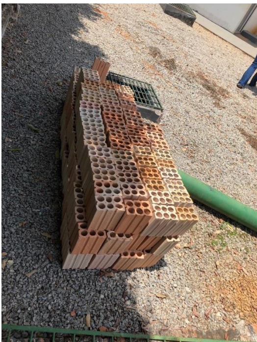
Figura 20 - Ausência de local adequado para o armazenamento dos materiais de trabalho (Data: 10/10/2019)
