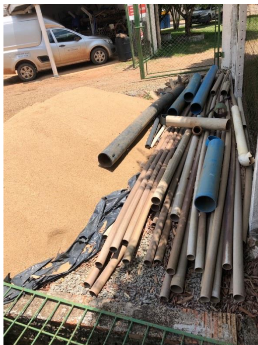
Figura 21 - Ausência de local adequado para o armazenamento dos materiais de trabalho (Data: 10/10/2019)
