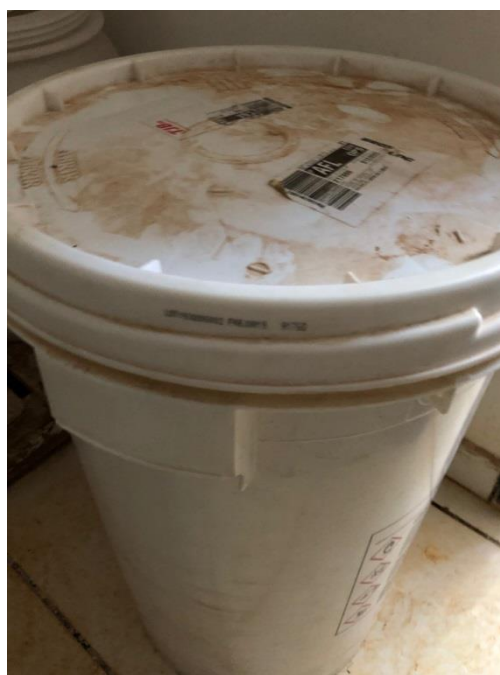
Figura 23 - Estocagem inadequada de produtos químicos – NBR 12216/92 (Data: 10/10/2019)
