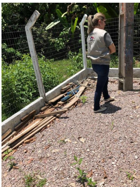
Figura 03 - Conservação e limpeza do pátio comprometida (Data: 10/10/2019)
