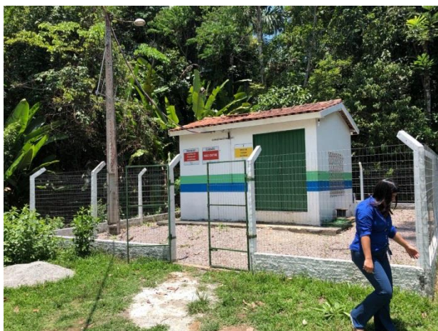
Figura 01 – Ausência de Placa de Identificação (Data: 10/10/2019)
