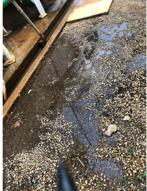
Figura 17 - Rede de drenagem de água insuficiente NBR 12216/92 (Data: 10/10/2019)
