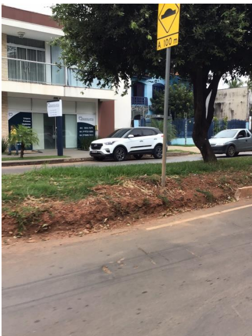
Figura 10 – Canteiro sem meio-fio no cruzamento com a Rua das Cerejeiras (Data:15/05/2019).
