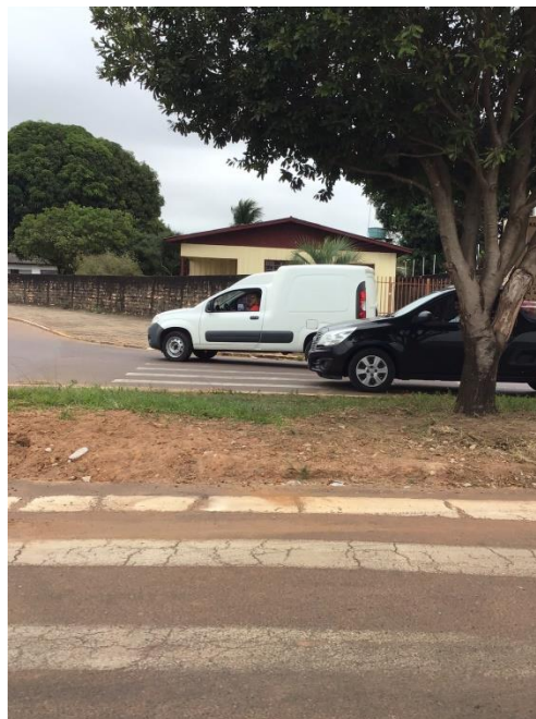
Figura 8 - Canteiro sem meio-fio no cruzamento com a Av. dos Flamboyants (Data: 15/05/2019).
