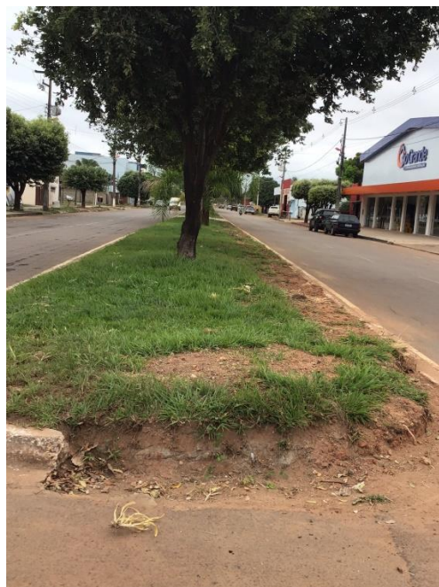
Figura 3 - Canteiro sem meio-fio no cruzamento com a Rua dos Marupás (Data: 15/05/2019).
