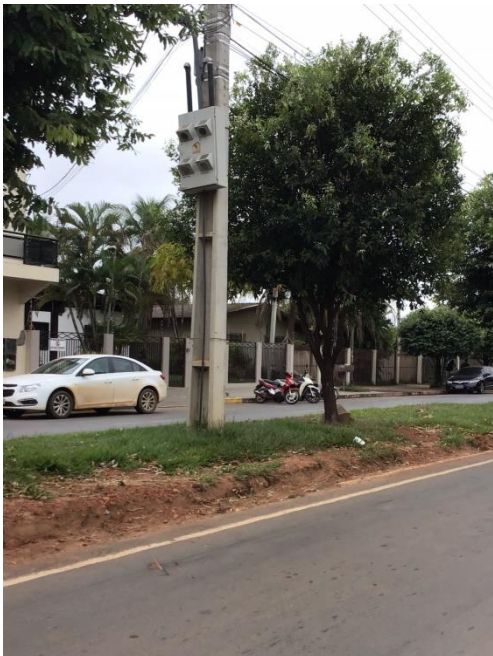
Figura 9 - Canteiro sem meio-fio próximo ao cruzamento com a Rua dos Cedros (Data: 15/05/2019).
