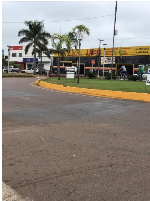
Figura 11 - Asfalto com fundamento no cruzamento com Avenida das Tarumãs.
