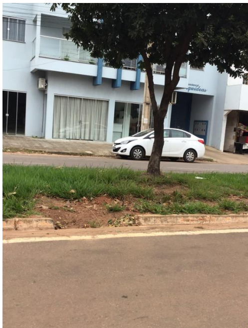
Figura 5 - Canteiro sem meio-fio em frente ao Residencial Orquídeas (Data: 15/05/2019).
