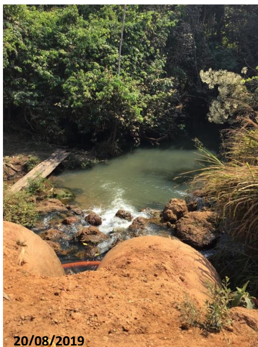
6 – Córrego Iva após extravasamento
