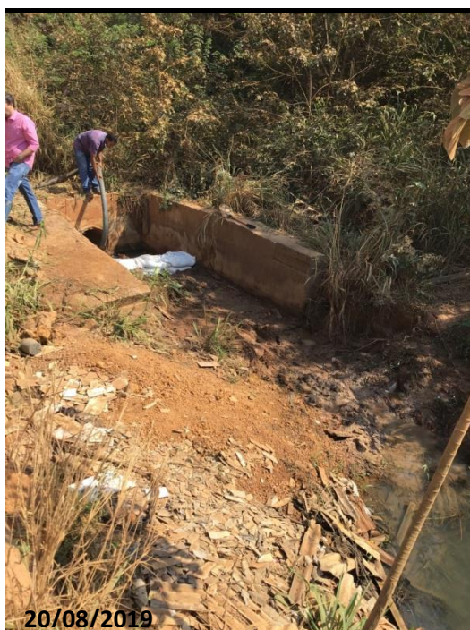
5 – Limpeza nas tubulações no córrego Iva
