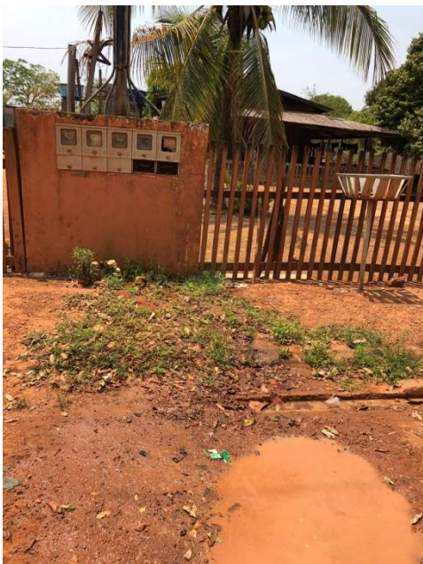
Figura 5 – Extensão do vazamento (Data: 23/09/2019).
