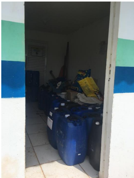
Figura 70 - Estocagem inadequada de produtos químicos. NBR 12216/92 (Data: 25/10/2019)
