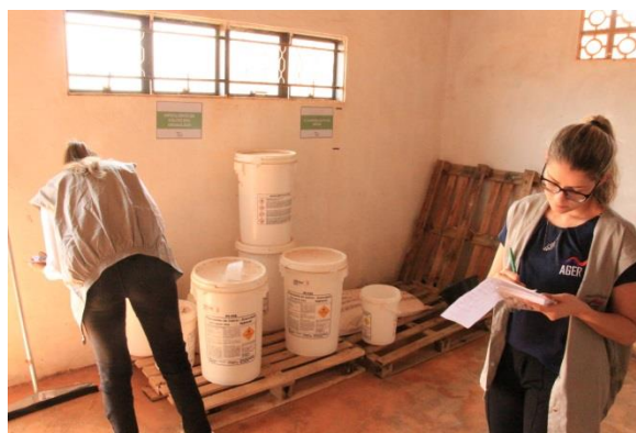
Figura 48 - Estocagem inadequada de produtos químicos. NBR 12216/92 (Data: 30/09/2019)
