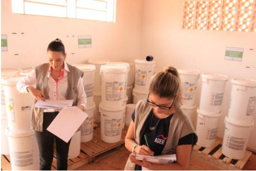
Figura 53 - Estocagem inadequada de produtos químicos. NBR 12216/92 (Data: 30/09/2019)
