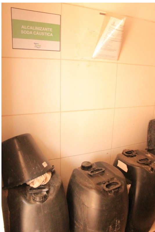
Figura 14 – Armazenamento inadequado dos produtos químicos. NBR 12219-96 (Data: 25/09/2019)
