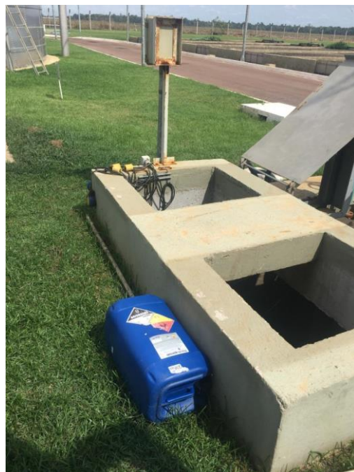
Figura 67 - Armazenamento inadequado de utensílios. (Data: 25/10/2019)
