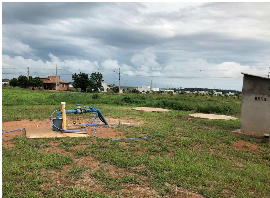
Figura 7 - Ausência de isolamento da área, de placa de identificação e alerta de restrição de uso e de iluminação noturna (Data: 16/12/2019).
