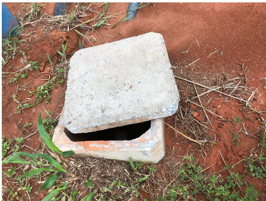
Figura 6 - Caixa de inspeção aberta (Data: 16/12/1990).
