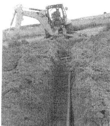
Figura 6. Obras para ativação do poço de 35m 3 /h
