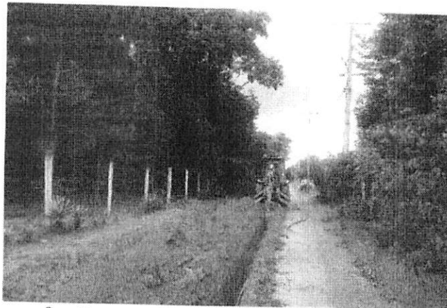
Figura 9. Abertura de vala para passagem da rede de água
