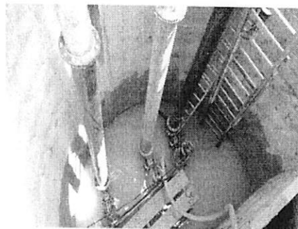
MONTAGEM DAS BOMBAS - EEE 05
