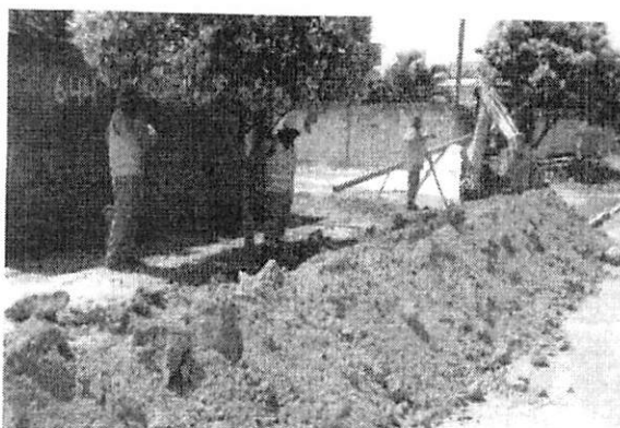
Figura 32. Obras de ampliação de rede coletora
