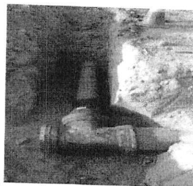
Figura 21. Escavação e tubulação da rede adutora
