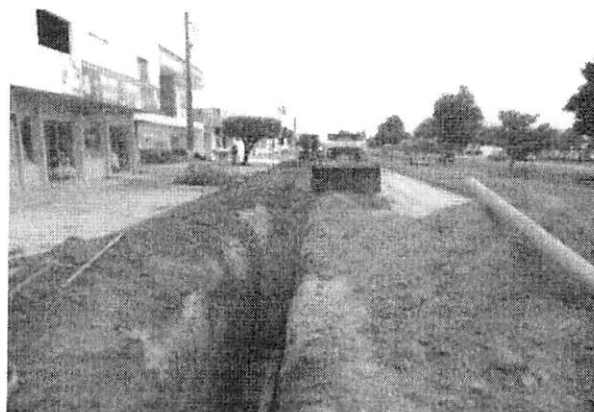
Figura 37. Implantação de rede de esgoto.
