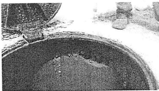
PV na esquina da Rua Guaimbés com Violetas: Sem acabamento lateral
