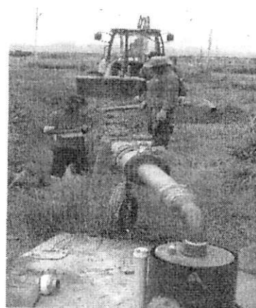
Figura 7. Obras para ativação do poço de 35m 3 /h
