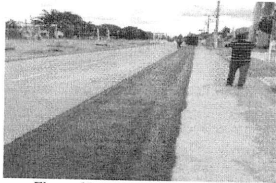
Figura 29. Recomposição asfáltica
