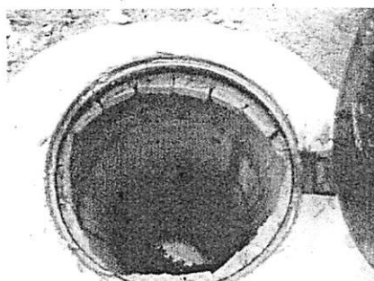
PV na esquina da Rua Piracantas com Pacaris: Sem acabamento lateral e sem limpeza no fundo
