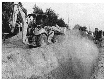
REATERRO DA VALA
