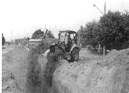
REATERRO DA VALA
