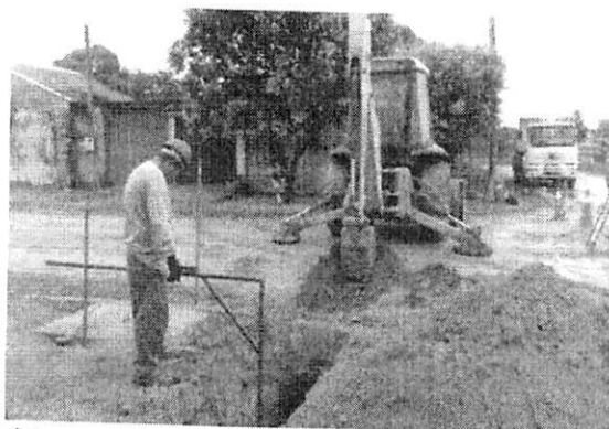
Figura 31. Abertura de vala para passagem da rede de esgoto
