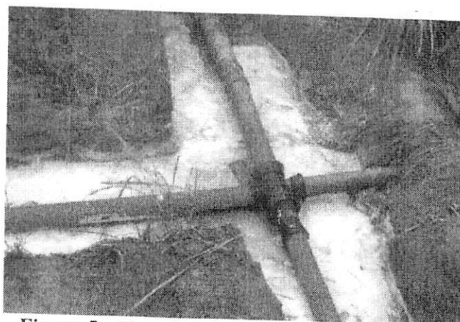
Figura 5. Obras de interligação de rede de água
