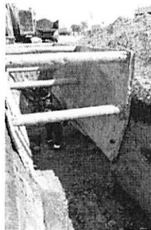
ASSENTAMENTO DE TUBO
