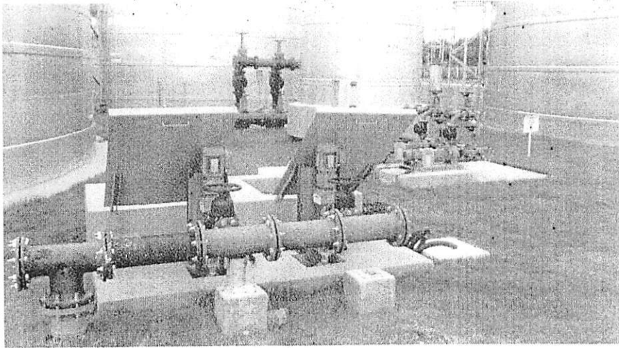
Figura 12 - Bombas de retorno de lodo e de espuma secundária finalizadas
