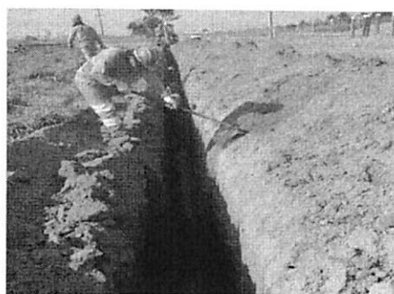
ASSENTAMENTO DE TUBO
