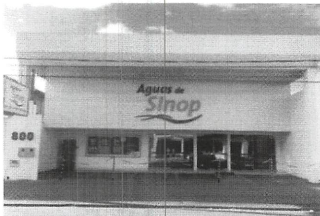
Figura 1. Fachada – Águas de Sinop
