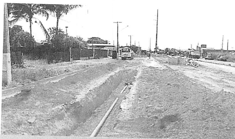
Posicionamento de tubo para execução da rede coletora
