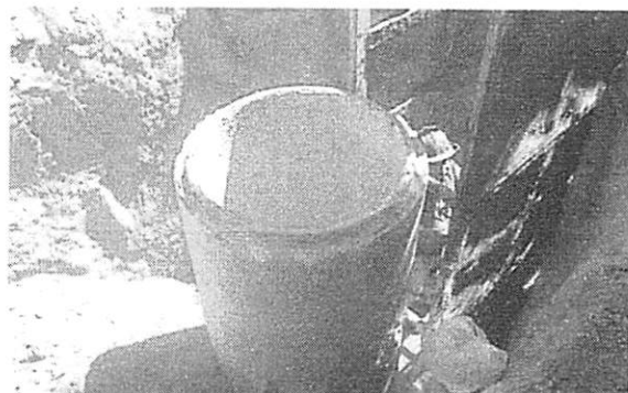
Execução de poço de visita
