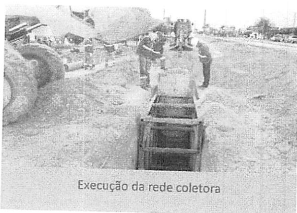
Escavação e execução da rede coletora
