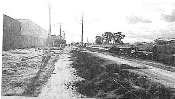
Escavação e marcação para execução da rede coletora
