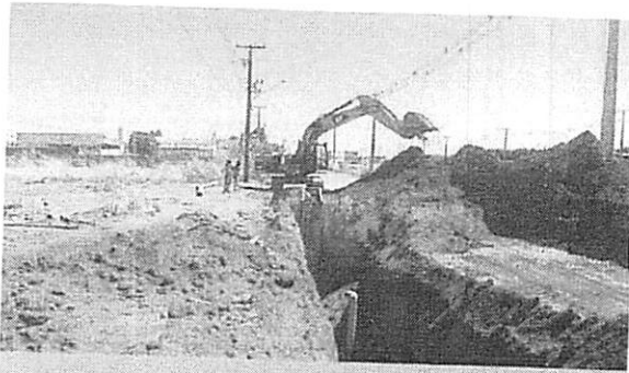
Processo de escavação e tubulação do coletor
