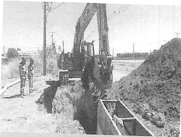
Execução de rede coletora
