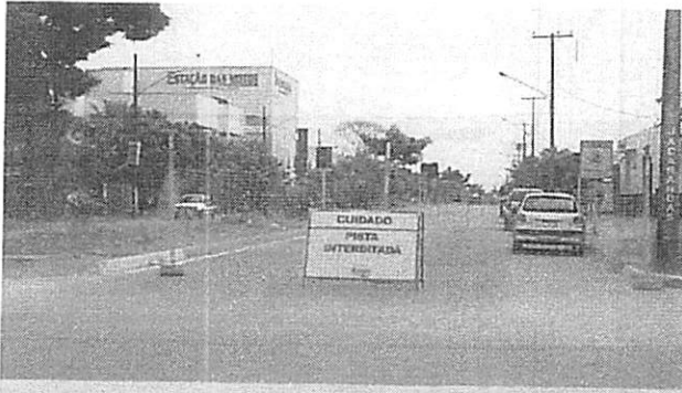
Sinalização das obras de esgotamento sanitário
