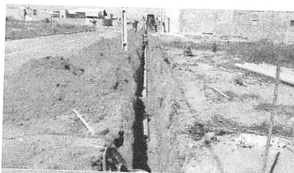
Execução de rede coletora
