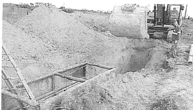
Escavação para execução da rede coletora
