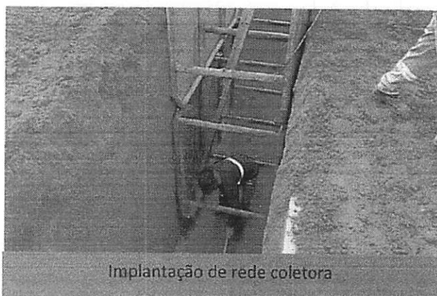
Execução de rede coletora
