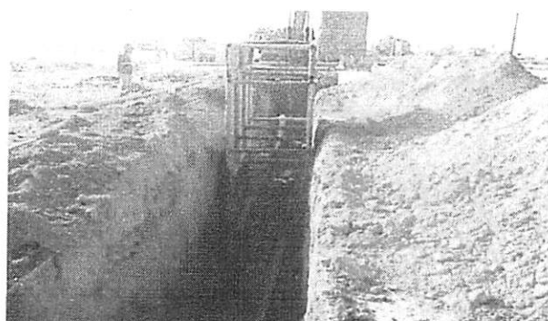
Execução de rede coletora
