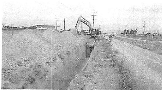
Execução de rede coletora
