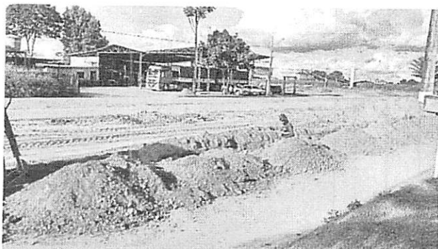
Escavação para execução da rede coletora
