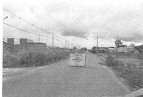
Sinalização das obras de esgotamento sanitário
