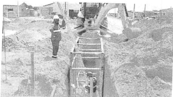
Execução de rede coletora
