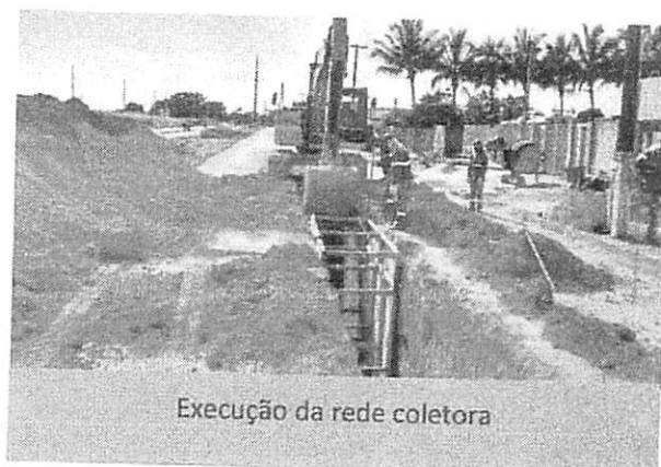
Escavação e execução da rede coletora
