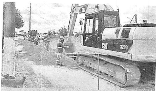
Escavação e execução da rede coletora
