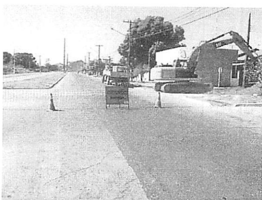
Sinalização das obras de esgotamento sanitário
