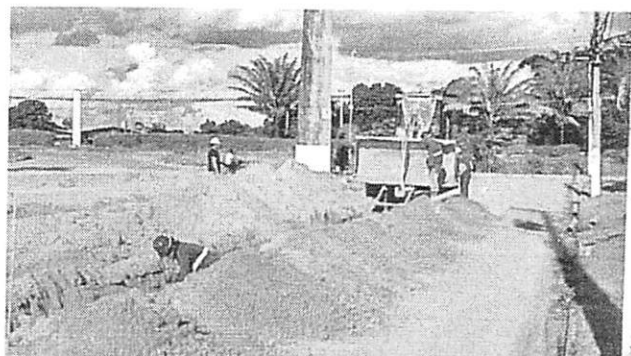
Escavação para execução da rede coletora
