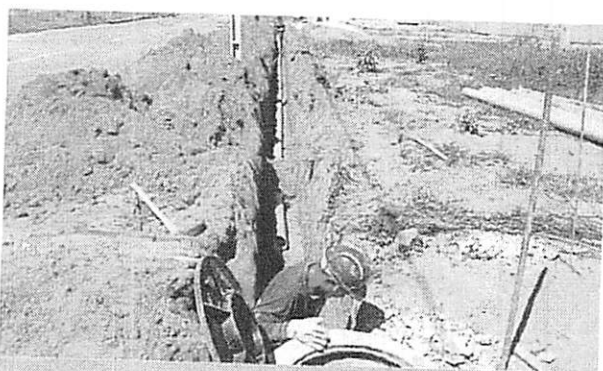
Execução de rede coletora e poço de visita
