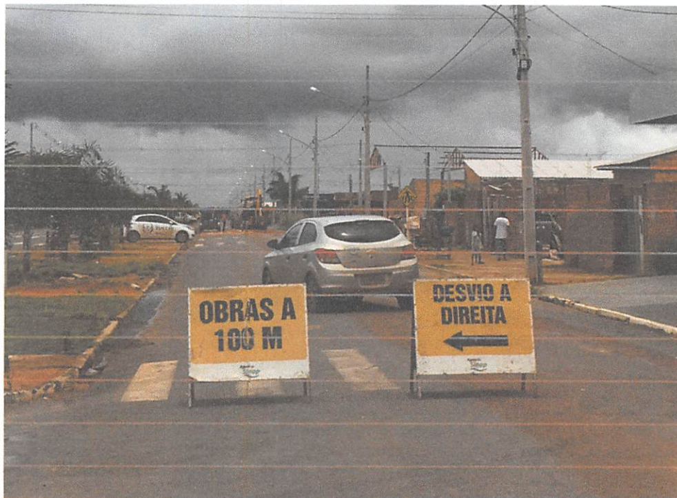
Figura 7 – Via interditada com sinalização de obras.
