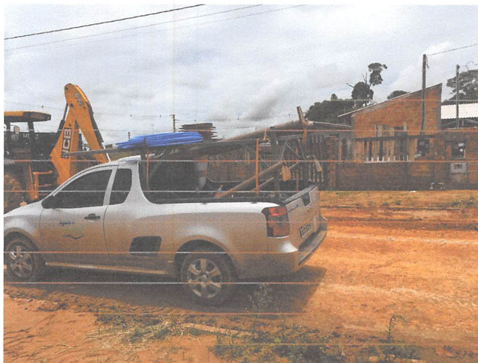
Figura 4 - Concessionária Águas de Sinop iniciando os reparos em um dos pontos na Av. José Naeno (Data:01/03/2019).
