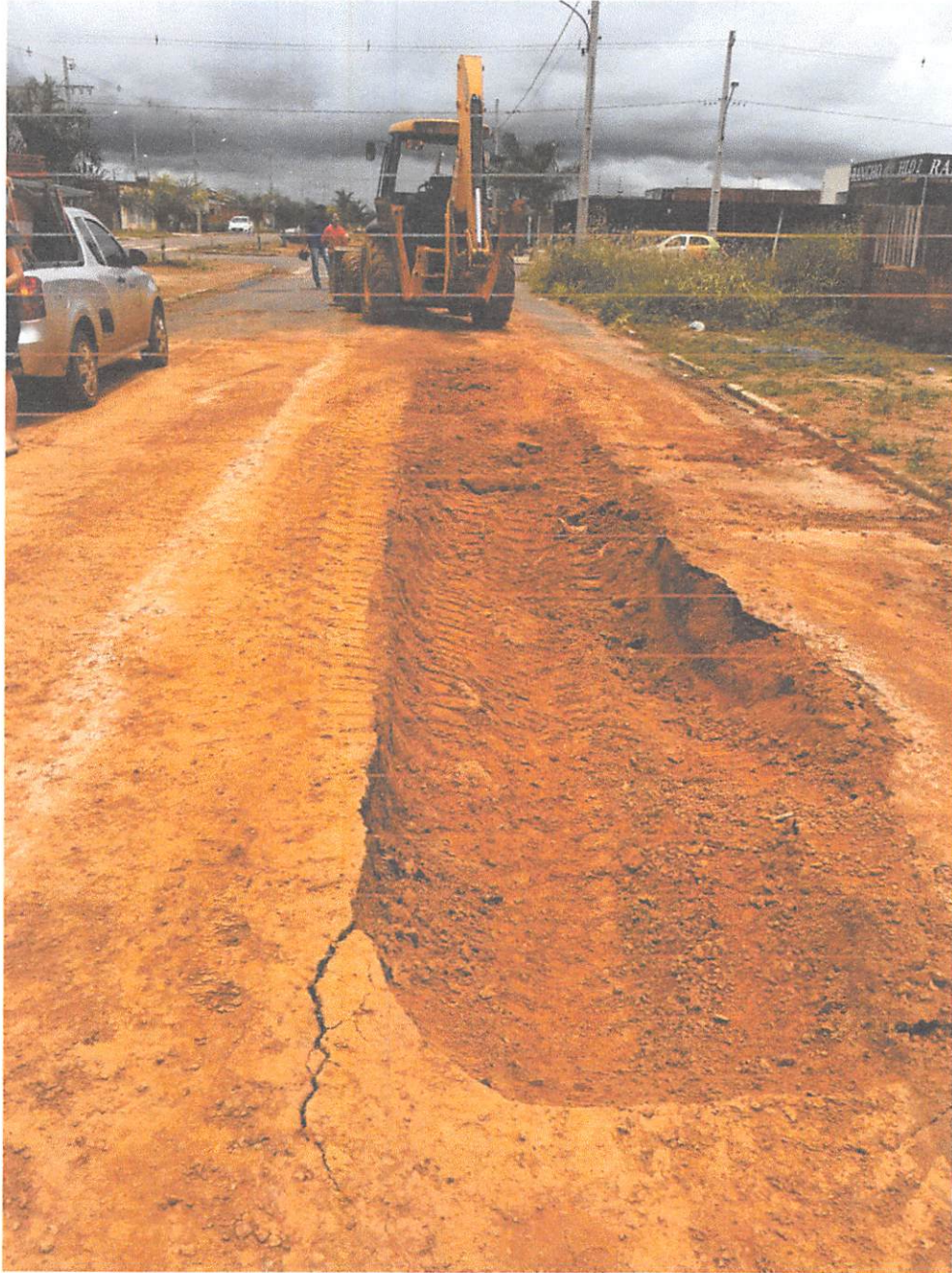
Figura 5 - Retirada da camada asfáltica para reparo (Data: 01/03/2019).
