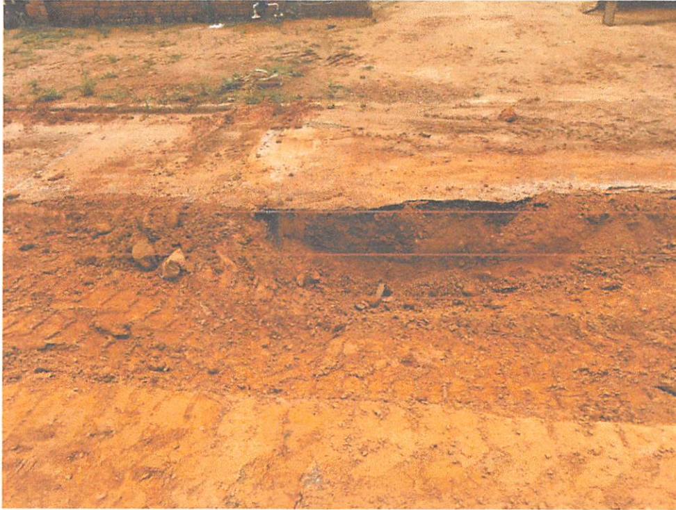
Figura 6 - Retirada da camada asfáltica para reparo (Data: 01/03/2019).
